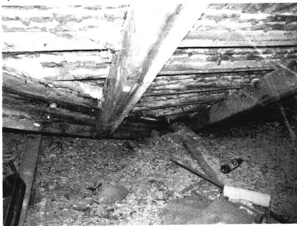
Widok krokwi koszowej od strony południowo- wschodniej budynku na złączu dwóch połaci dachu.
