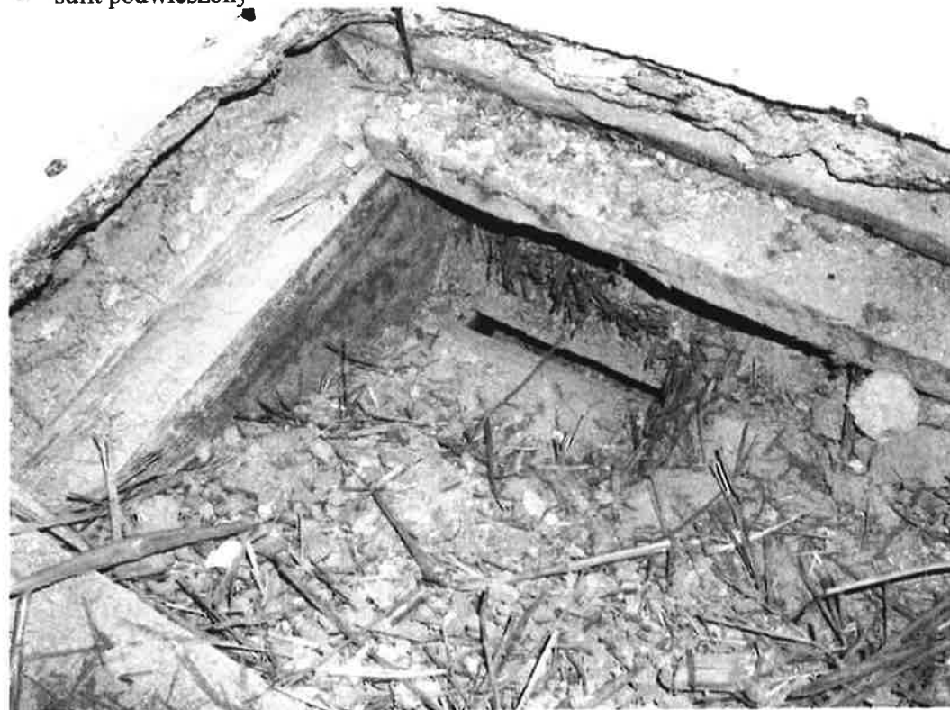
odkrywka w sali nauki religii w północnej części budynku
