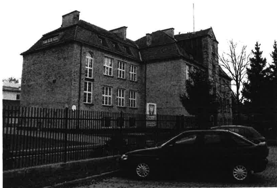
Elewacja wschodnia i południowa budynku.
